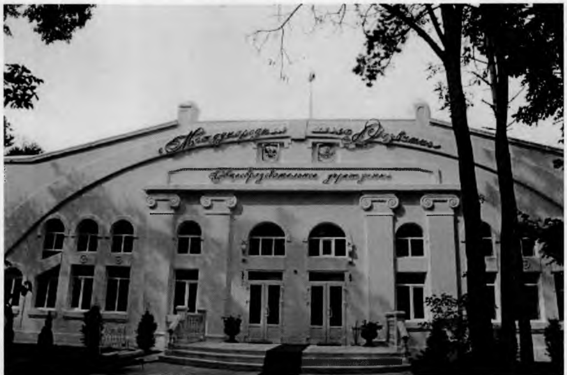
Рис. 10. Рянова И.Ю Главный фасад здания. Современный облик, 30.09.2015
