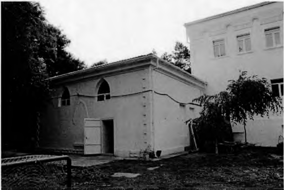
Рис. 4. Ряднова И.Ю Восточный фасад здания, 30.09.2015
