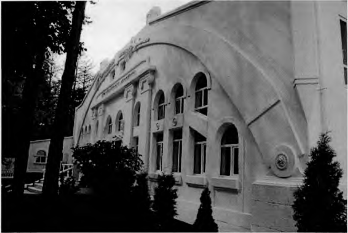
Рис. 3. И.Ю. Южный фасад здания, 30.09.2015
