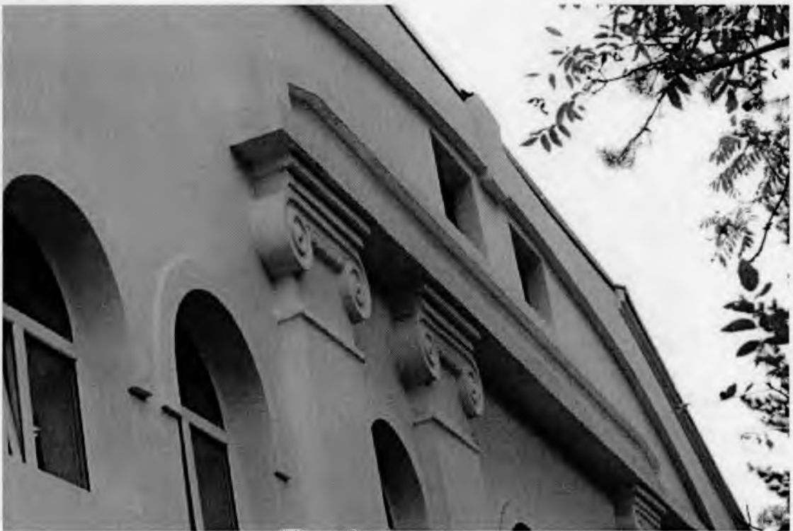
Рис. 8. Ряднова И.Ю Детали северного фасада, 30.09.2015
