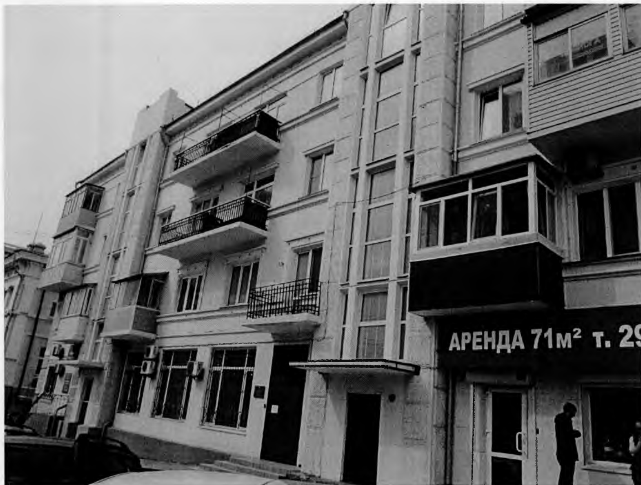
Главный фасад здания по ул. Фонтанная, д. 47
