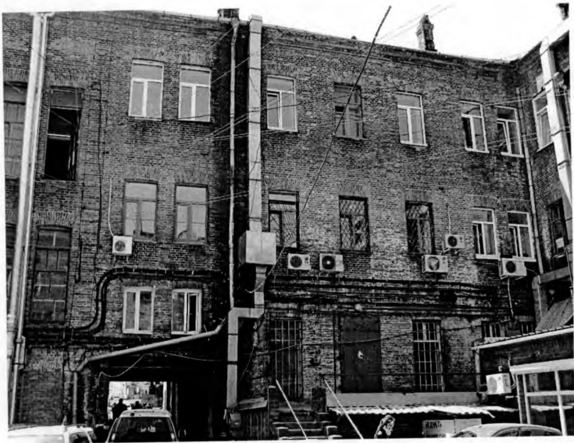
Дворовой фасад здания по ул. Светланская, д.7
