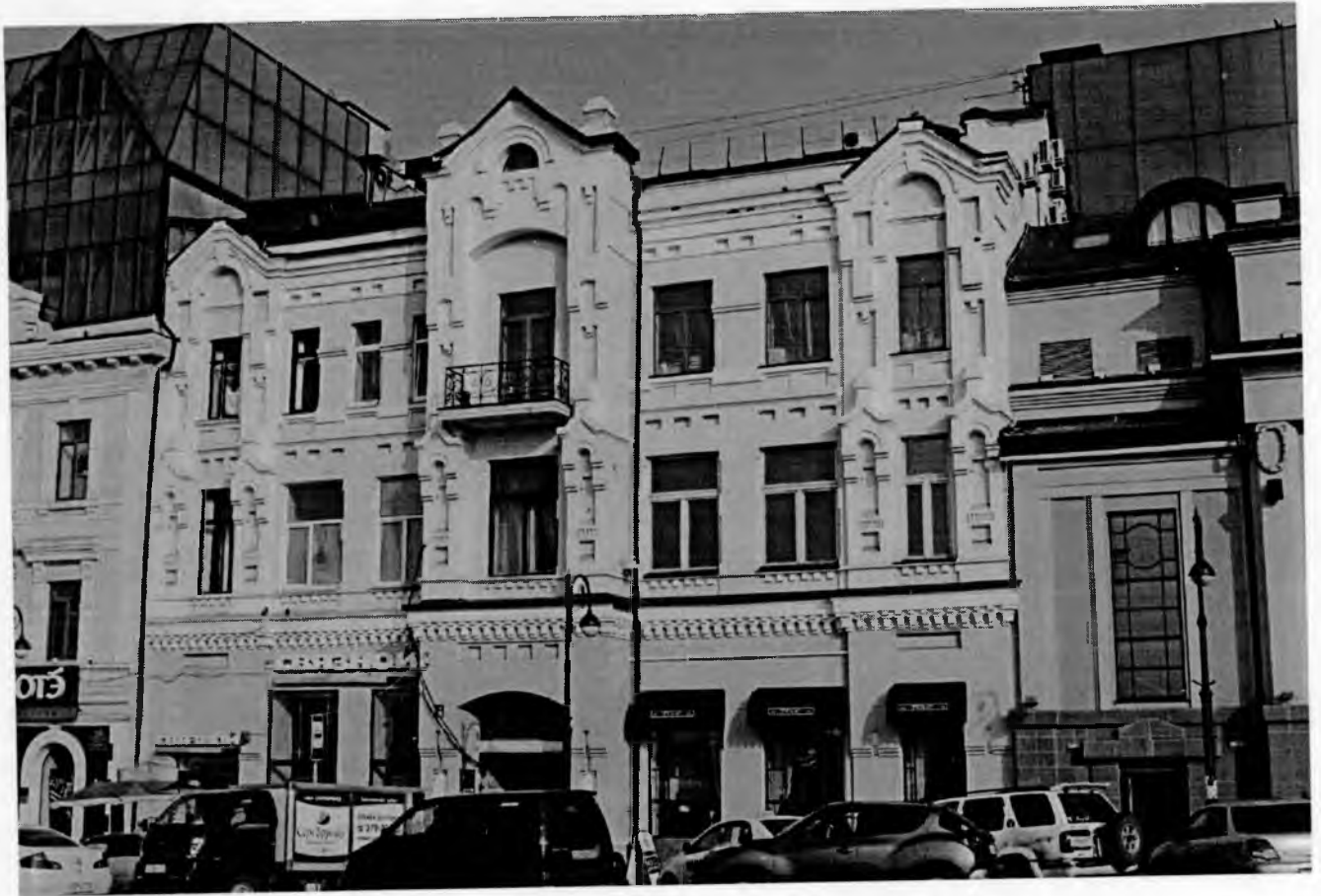
Главный фасад здания по ул. Светланская, д.31
