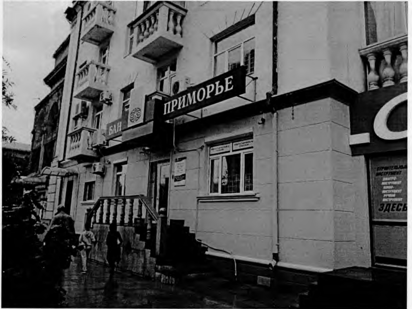
Главный фасад здания по ул. Калинина, д. 35
