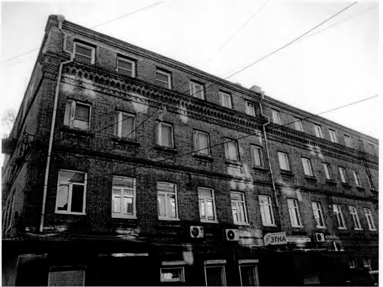
Северный фасад здания по ул. Пограничная, д. 12а
